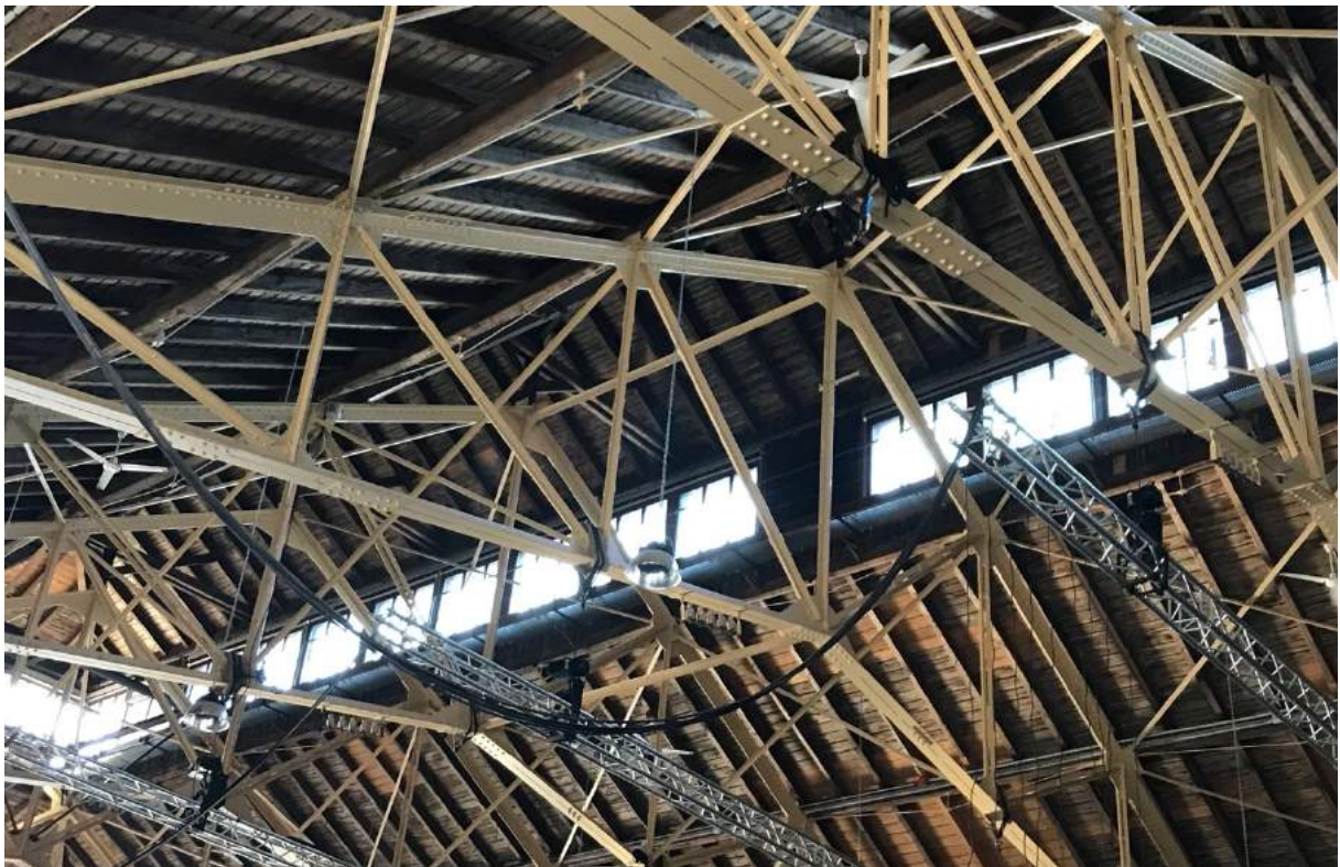
Die Fenster der Dachlaterne lassen wieder Licht in die Grosse Halle, Foto: Luzius Engel
